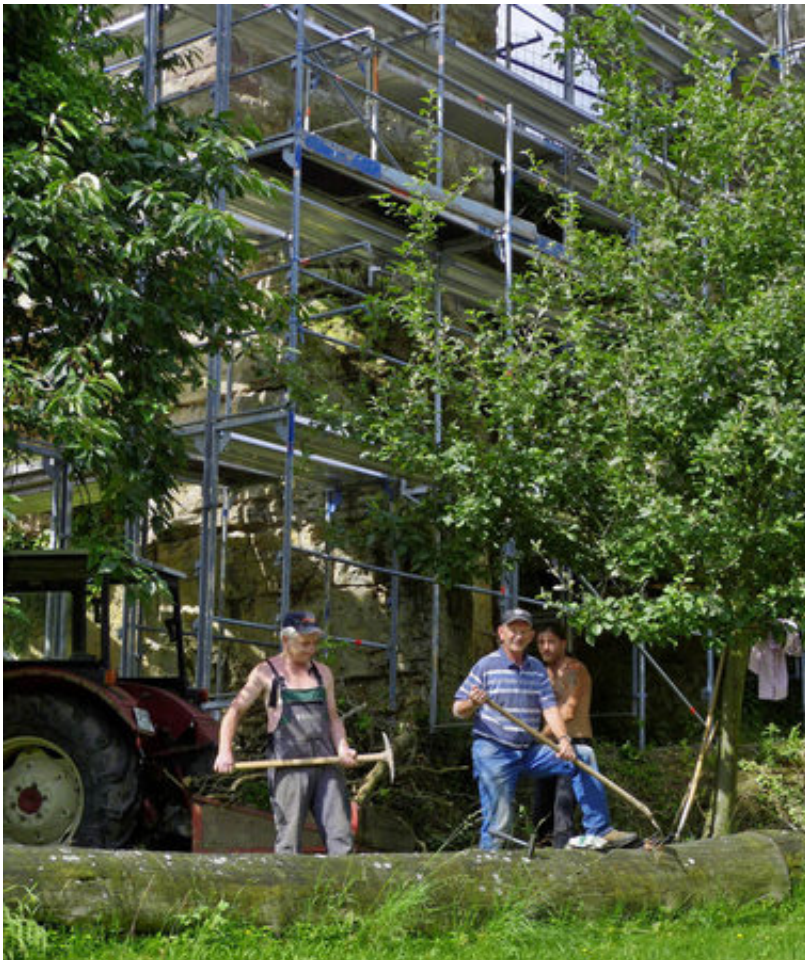
Nordwandsanierung Burgruine Landeck Foto: Aribert Rüssel
