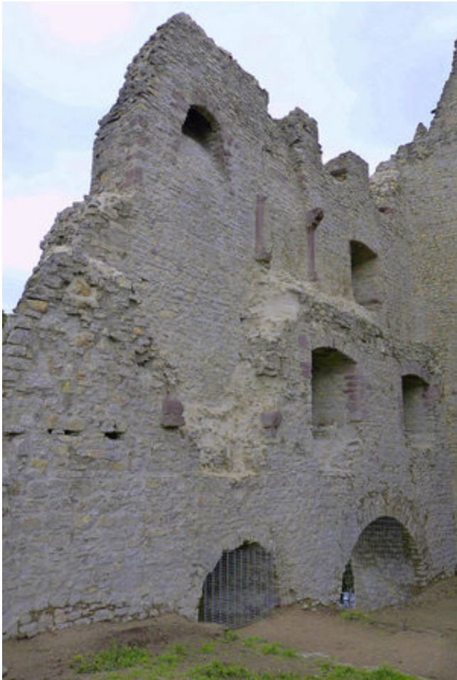
Sanierung der Nordwand der Burgruine Landeck Foto: Aribert Rüssel
